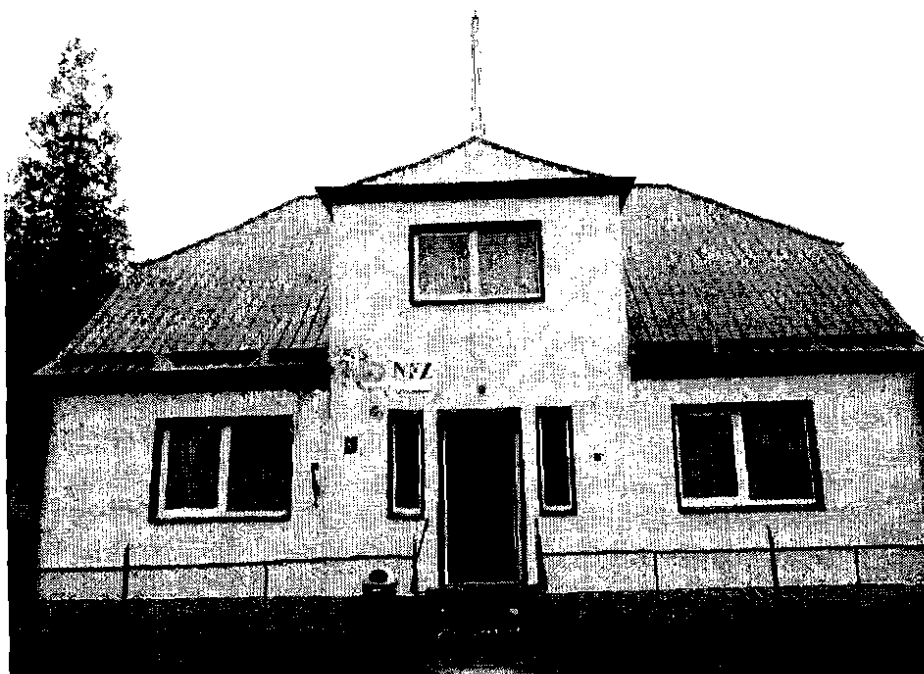
Fot. Nr 1 Budynek będący tematem opracowania.
