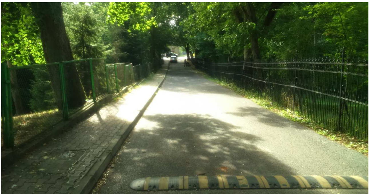
Zdj. 1. Widok ulicy Korczaka w miejscowości Damnica.
