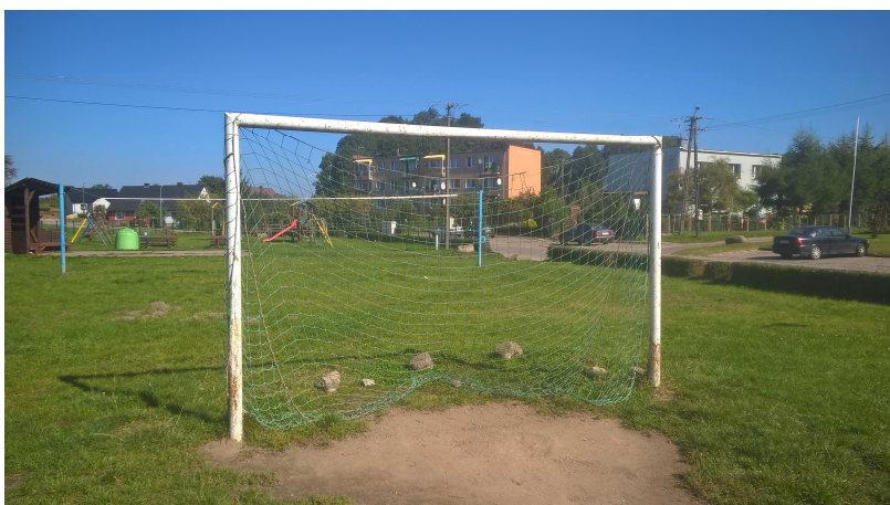
Urządzenie nr L – Bramka do gry w piłkę nożną do renowacji konstrukcja stalowa / do wymiany siatki – szt.2
