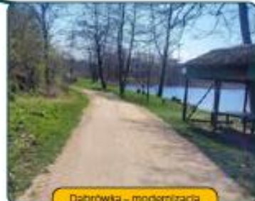
Dąbrówka – modernizacja drogi gminnej do jeziora Dąbrówka na odcinku 200 mb
