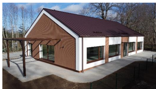
zakończenie budowy – kwiecień 2023
