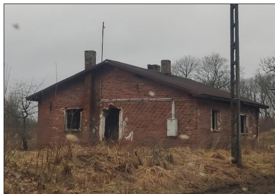
Fot. 5 Dom mieszkalny na dz. nr 116, obr. Wiszno – ujęty w ewidencji zabytków Źródło: archiwum własne
