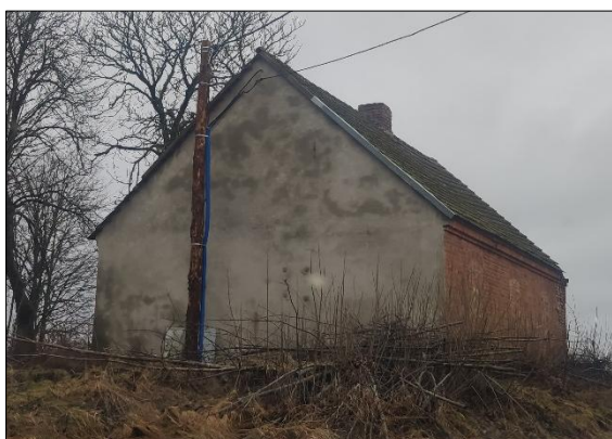
Fot. 6 Kuźnia na dz. nr 6/9, obr. Wiszno – ujęta w ewidencji zabytków Źródło: archiwum własne
