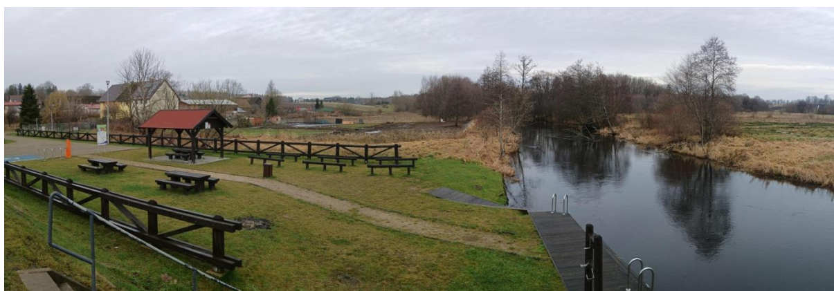
Fot. 6. Infrastruktura przystani kajakowej w Damnie nad Łupawą, widok z mostu na drodze Damno – Bobrowniczki w kierunku północnym
