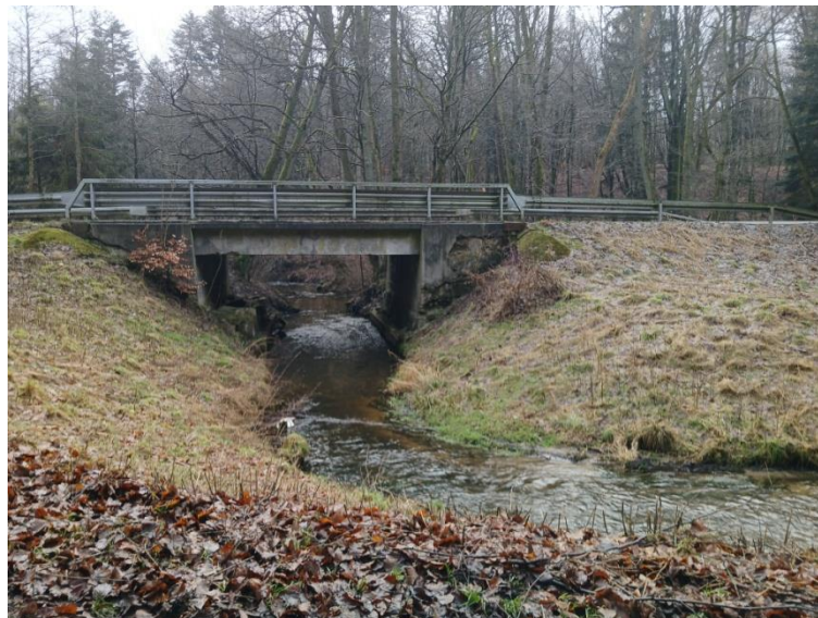
Fot. 2. Charstnica niedaleko ujścia do Łupawy, na zachód od Damnicy, widok ku południowemu wschodowi
