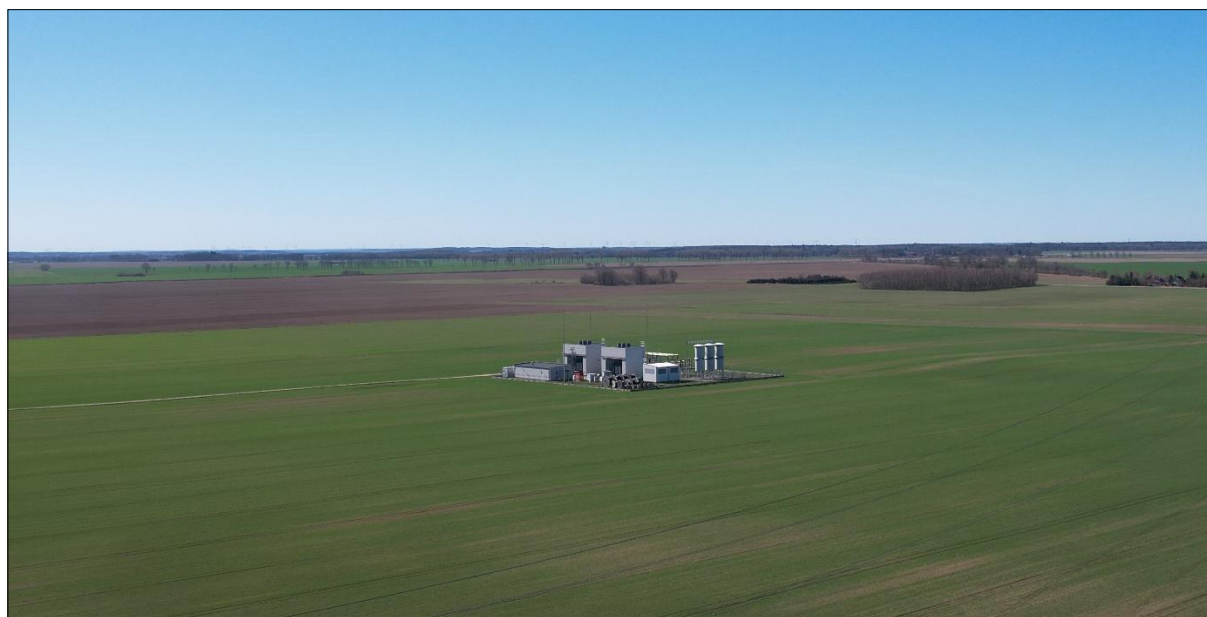
Fot. 1 Stacja elektroenergetyczna GPO Biećino Źródło: archiwum własne.
