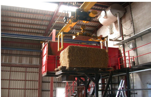
Rys. nr 9 Kotłownia na słomę o mocy 6 MW (Dania)
