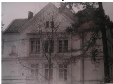
Ściana wschodnia pałacu, lata 60 lub 70.
