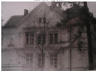
Ściana wschodnia pałacu, lata 60 lub 70.
